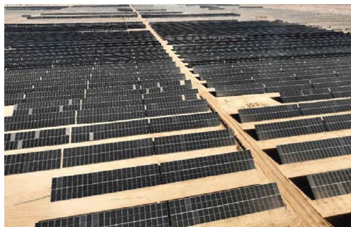
240MW 新疆一师地面光伏项目
