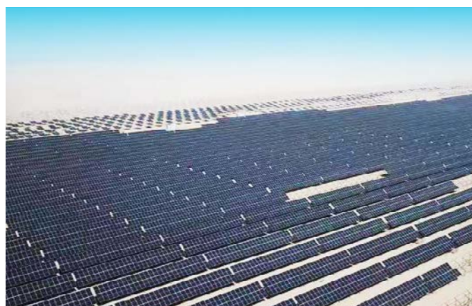
100MW 青海海西州耐候钢地面光伏项目
