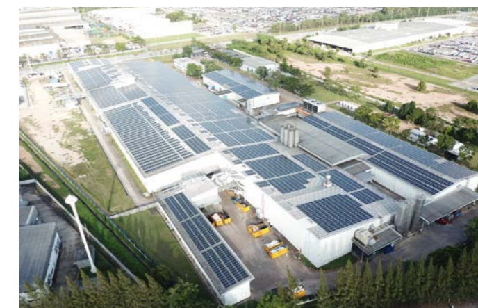
3.3 MW 泰国罗勇府分布式光伏项目
