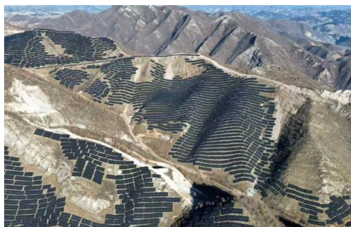
100MW 河北秦皇岛地面光伏项目
