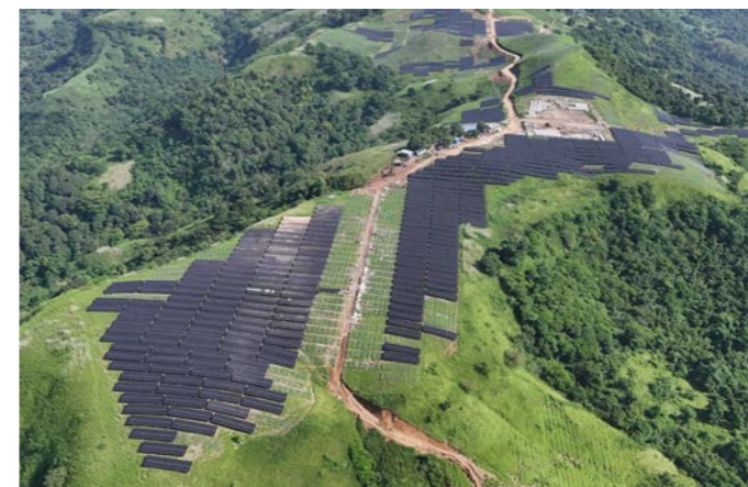
221MW 菲律宾奥隆阿坡地面光伏项目
