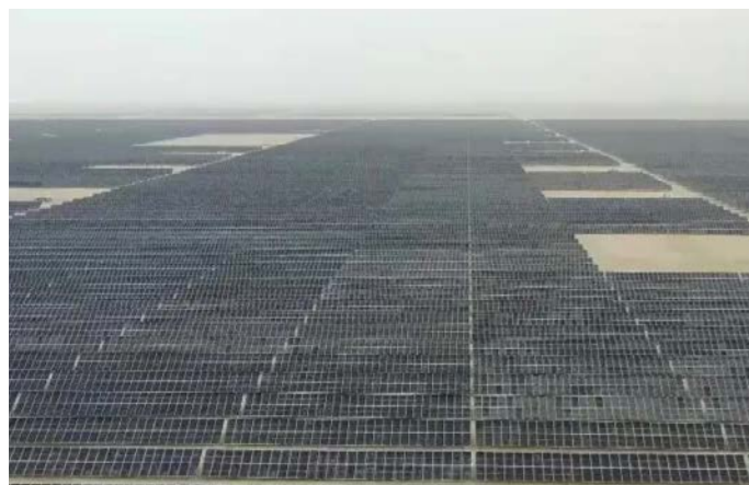
300MW 新疆若羌地面光伏项目
