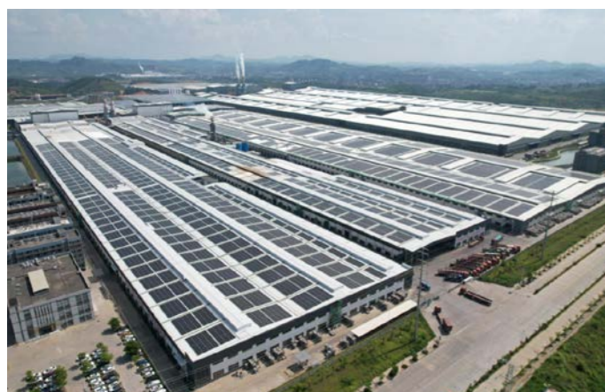
40MW 广西梧州分布式光伏项目
