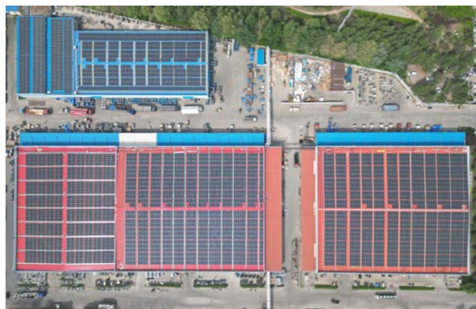
60MW 山东东营分布式光伏项目
