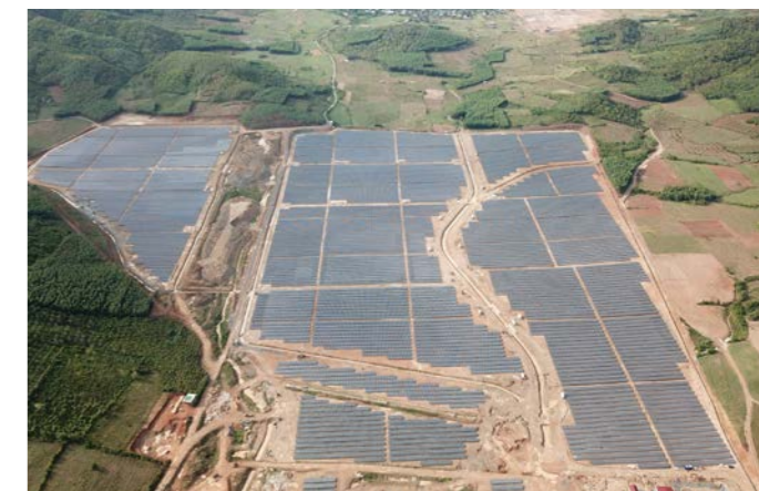
100MW 越南清化地面光伏项目
