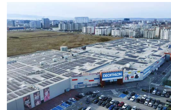
4.6MW 罗马尼亚购物中心分布式光伏项目
