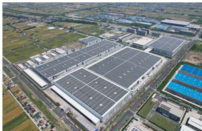
40.8MW 江苏东台分布式光伏项目
